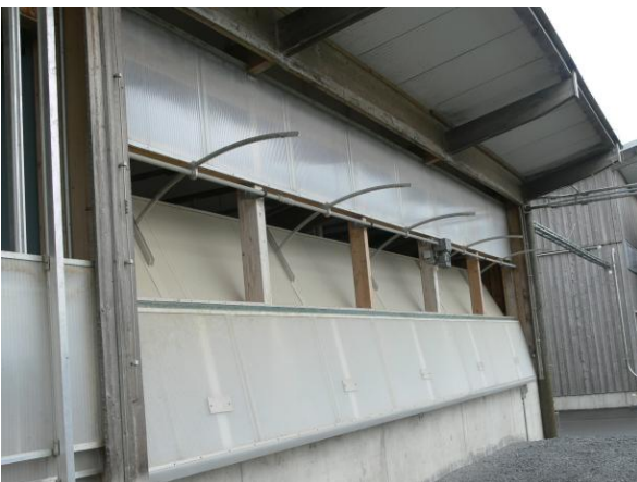
Bild 8 und 9: Wendeklappe mit einer Lichtstegplatte und Zahnstangenantrieb im Abteil D
