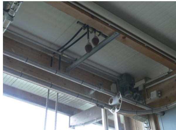
Bild 6 und 7: Schiebefenster mit 3 Lichtstegplatten und Kettenantrieb im Abteil C
