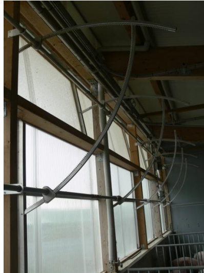
Bild 4 und 5: Ausstellfenster mit 2 Lichtstegplatten und Zahnstangenantrieb im Abteil B
