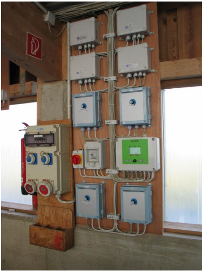
Bild 12 und 13: Schalttafel für Abteilregelsystem, Regel- und Steuergerät im Abteil
