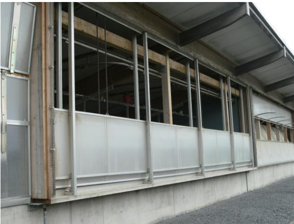
Bild 6 und 7: Schiebefenster mit 3 Lichtstegplatten und Kettenantrieb im Abteil C
