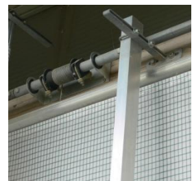
Bild 1 - 3: Wickelöffnung mit einer Gewebefolie und Hinterlagenetz, mittig wickelnd mit der Möglichkeit oben und unten zu öffnen im Abteil A
