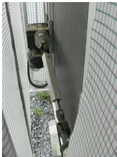
Bild 1 - 3: Wickelöffnung mit einer Gewebefolie und Hinterlagenetz, mittig wickelnd mit der Möglichkeit oben und unten zu öffnen im Abteil A
