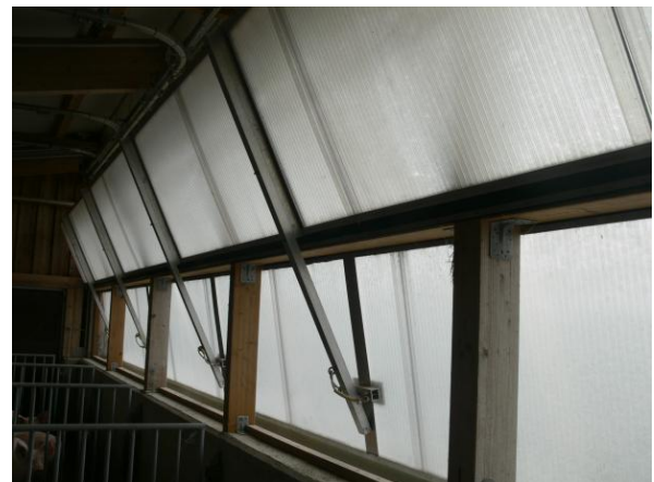
Bild 8 und 9: Wendeklappe mit einer Lichtstegplatte und Zahnstangenantrieb im Abteil D
