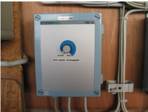
Bild 14 und 15: Steuergerät für manuelle Bedienung, Sensor im Kistenbereich
