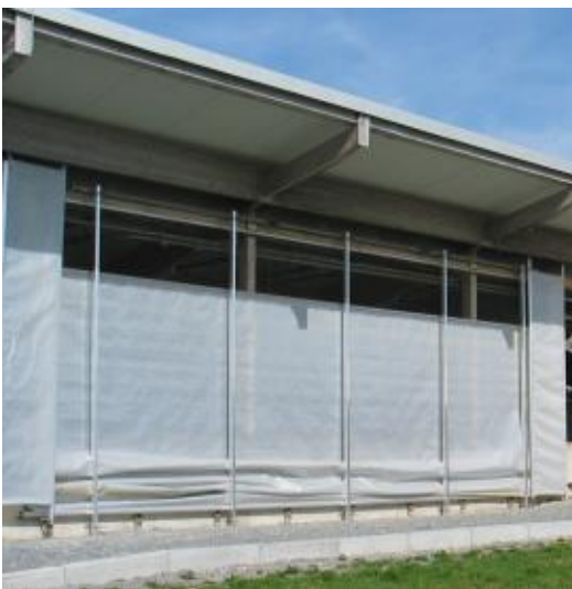
Bild 1 - 3: Wickelöffnung mit einer Gewebefolie und Hinterlagenetz, mittig wickelnd mit der Möglichkeit oben und unten zu öffnen im Abteil A
