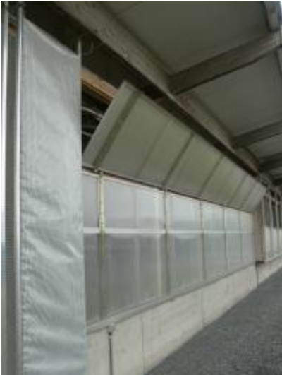
Bild 4 und 5: Ausstellfenster mit 2 Lichtstegplatten und Zahnstangenantrieb im Abteil B
