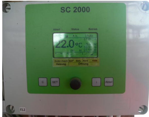
Bild 12 und 13: Schalttafel für Abteilregelsystem, Regel- und Steuergerät im Abteil
