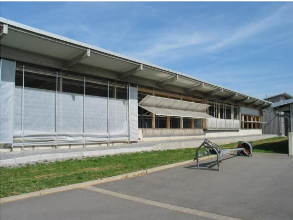
Bild 11: Frontöffnung in automatischer Lüftungsstellung (von oben öffnend)
